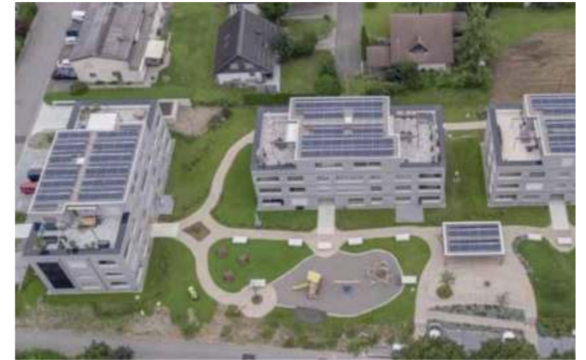
Plus-Energie-Siedlungen Möriken/AG (Minergie-P)
