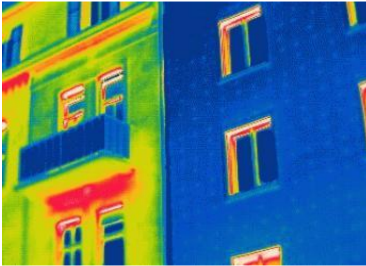
Sanierung des Bestands Bild: energiezukunftsweiz.ch
