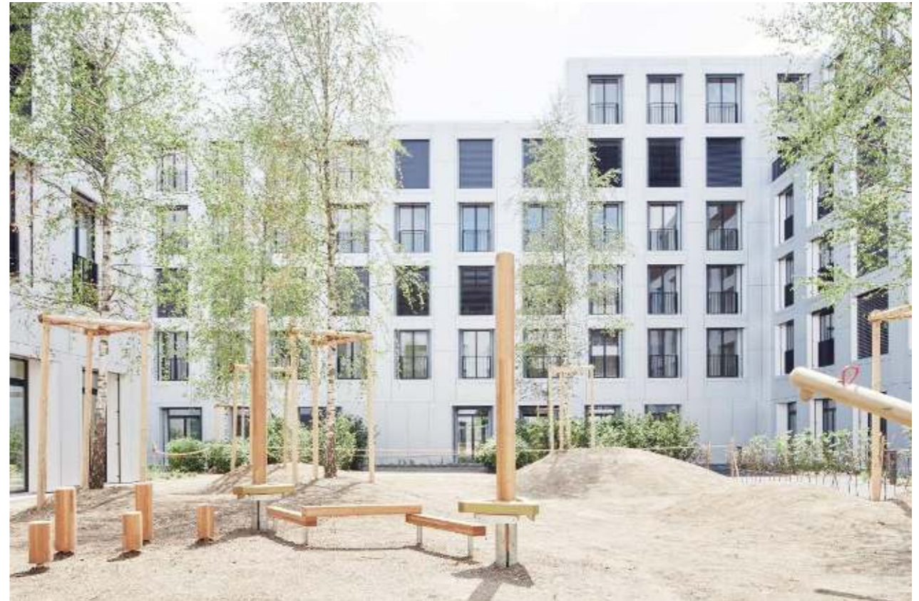
Grösster Holzbau der Schweiz: Wohnüberbauung sue&til Winterthur, Foto: Timbatec Holzbauingenieure AG
