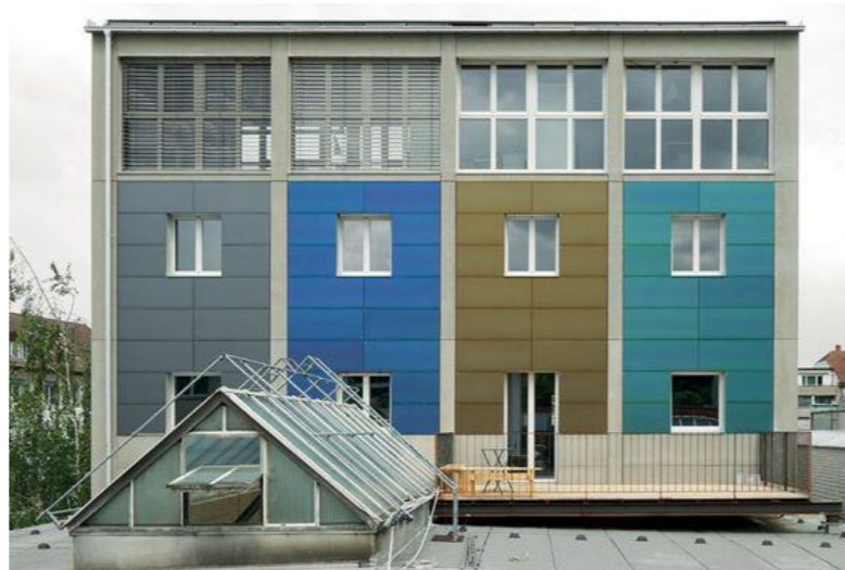
Ausbau von erneuerbaren Energien Bild Basler Kohlesilo / Solarpreis 2015
